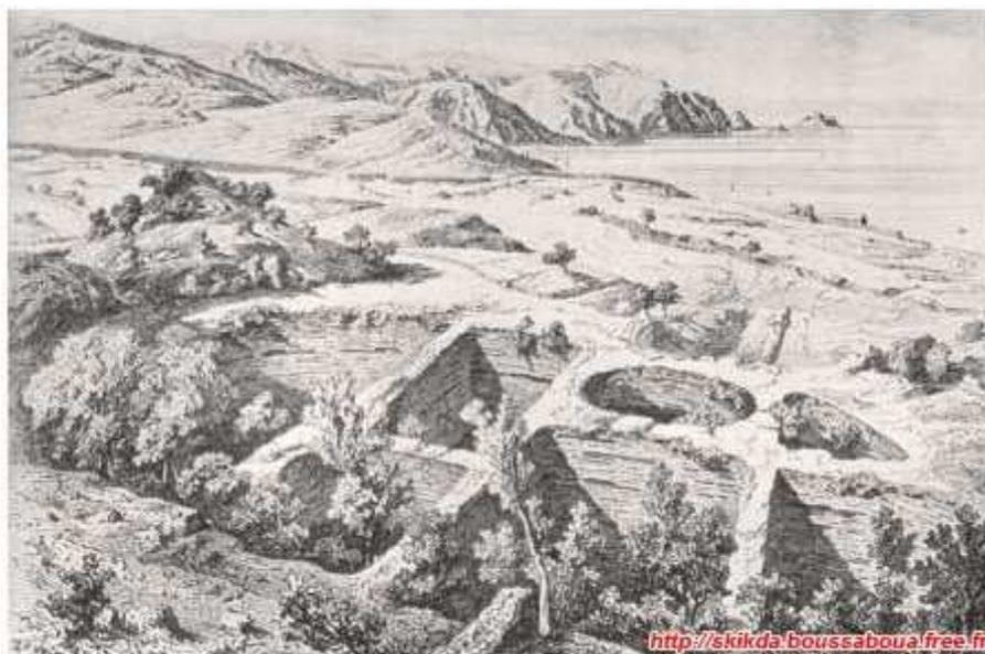
Ces citernes sont des types admirables de la conception romaine en hydraulique. Elles ont 25 mètres de long, 29 de large et 14m50 de profondeur. L'intérieur est divisé en six compartiments communiquant entre eux, et peuvent contenir 3 750m<sup>3</sup> d'eau. L'extérieur restauré, sans aucun goût, par des maçons modernes, ne donne pas l'impression de la beauté intérieure du travail romain.
